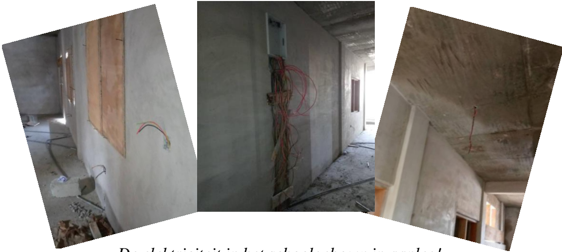
De elektriciteit in het schoolgebouw in aanleg!
